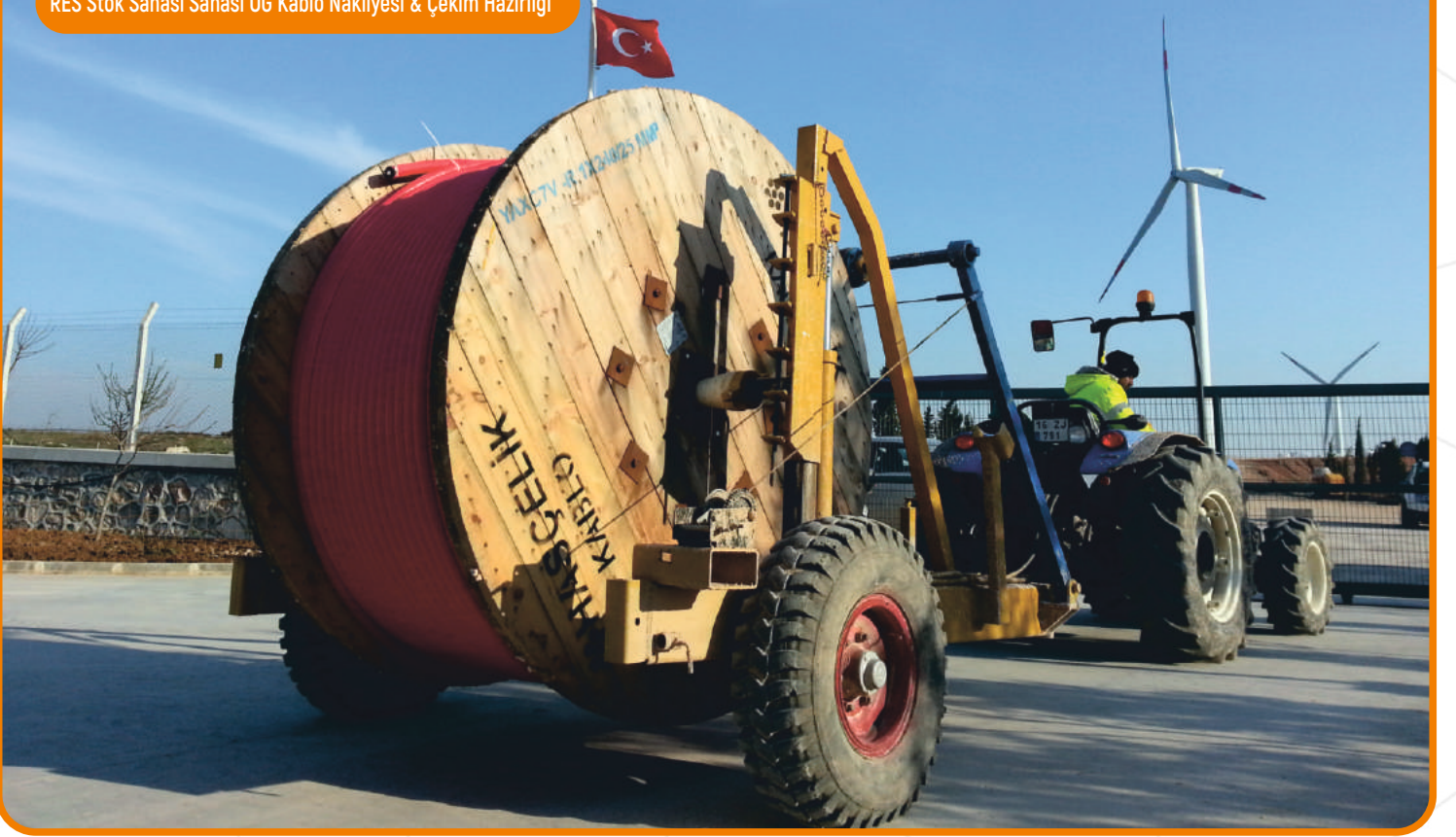
RES Stok Sahası Sahası OG Kablo Nakliyesi & Çekim Hazırlığı
